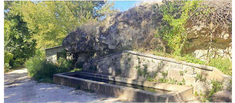
Lavadero de Villarejo del Espartal
